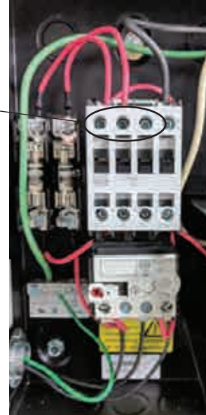
FIGURA 3A CONNESSIONI DI ALIMENTAZIONE DEI COMPRESSORI D'ARIA MODELLO TNGC-1150 PER LA REGIONE AMERICHE
