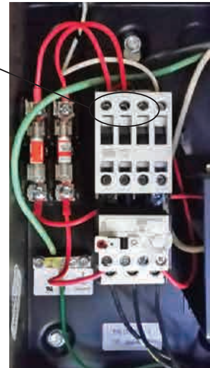
FIGURA 3B CONNESSIONI DI ALIMENTAZIONE DEI COMPRESSORI D'ARIA MODELLI TNGC-1500/2000/3000 PER LA REGIONE AMERICHE
